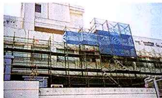
各病室ごとの空調がコントロール可能に
